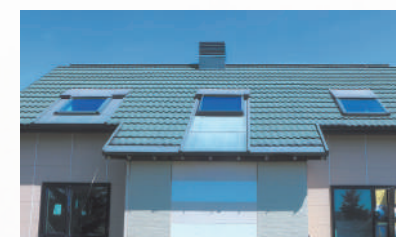
北海道旭川市 2002 年施工
